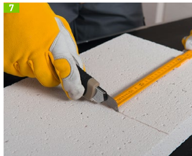
Passstücke können einfach mit einem Teppichmesser angerissen und geschnitten werden
