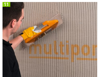
Multipor Gewebe als Armierungslage einbetten
