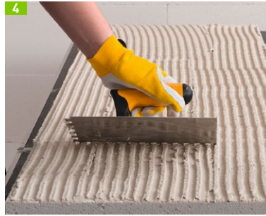
Wichtig ist der vollflächige Auftrag des Multipor Leichtmörtels quer zur Ansetzrichtung
