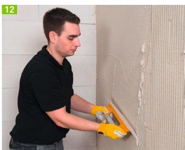
Abziehen der Armierungsschicht
