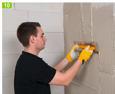
Multipor Leichtmörtel aufkämmen
