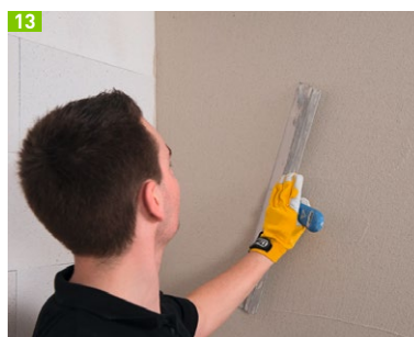
Glätten des Multipor Leicht- und Armierungsmörtels
