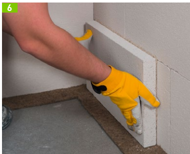
Multipor WI compact plus nach dem Andrücken 2 bis 3 cm verschieben, sodass die Stege umklappen und eine vollflächige Verklebung gewährleistet ist
