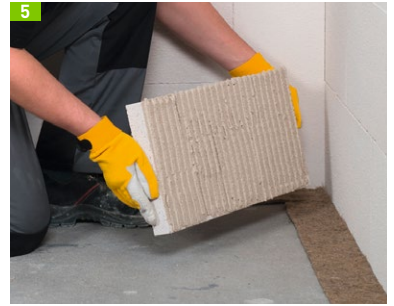
Platte mit den Stegen quer zur Schieberichtung ansetzen und andrücken
